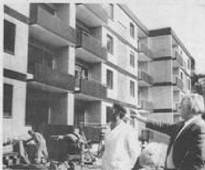
Rückblick in die Siebziger Jahre: 1971 begutachtete Albert Krukenberg jun. (r.) mit seinem langjährigen Polier Albert Bußmann die Baufortschritte an der Waldstraße.
