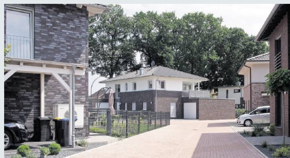
Die Bauarbeiten begannen im Jahr 2012. Das letzte Zweifamilienhaus wird im August dieses Jahres bezugsfertig sein.
